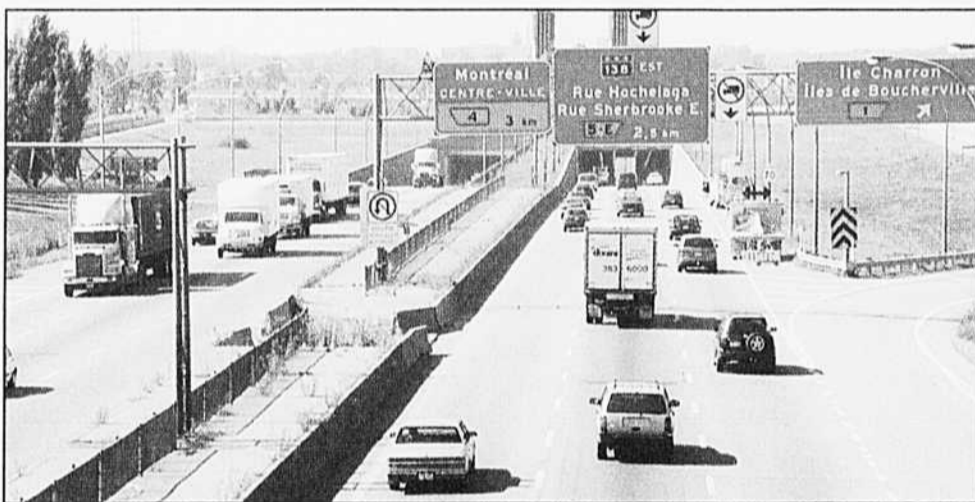
Le tunnel Louis-Hippolyte-La Fontaine accueille 125 000 visiteurs par jour (photo:Denys Houde - Ministère des Transports du Québec)
