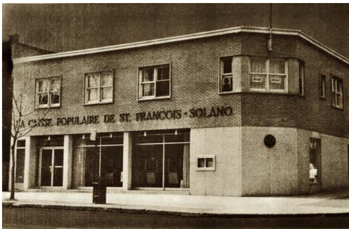
La caisse Saint-François-Solano en 1970 [collection ShRPP]
