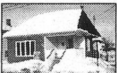
Rivière-du-Loup: Rue St-Alfred, résidence rénover, située dans un secteur près des écoles.
