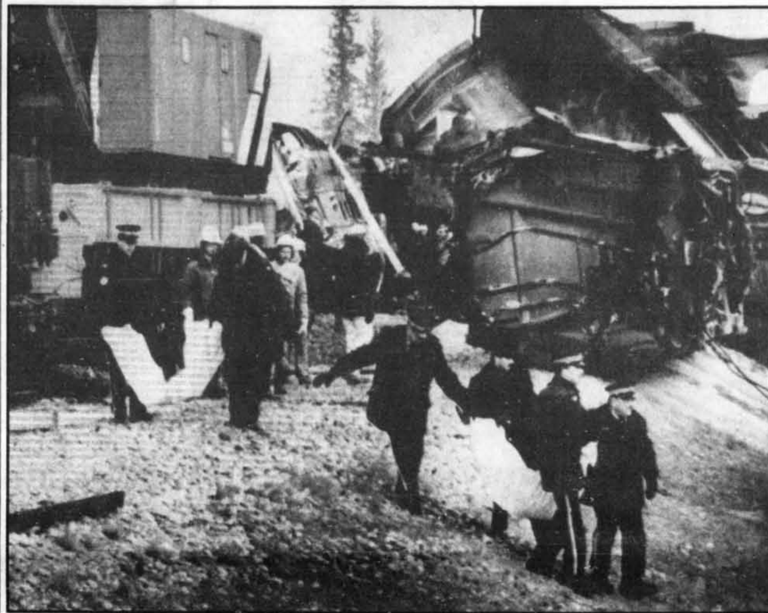
Les sauveteurs ne sont parvenus à dégager les deux premiers corps qu'hier matin. Il pourrait y avoir jusqu'à 50 victimes sous les amoncellements de débris. photocluser CP
