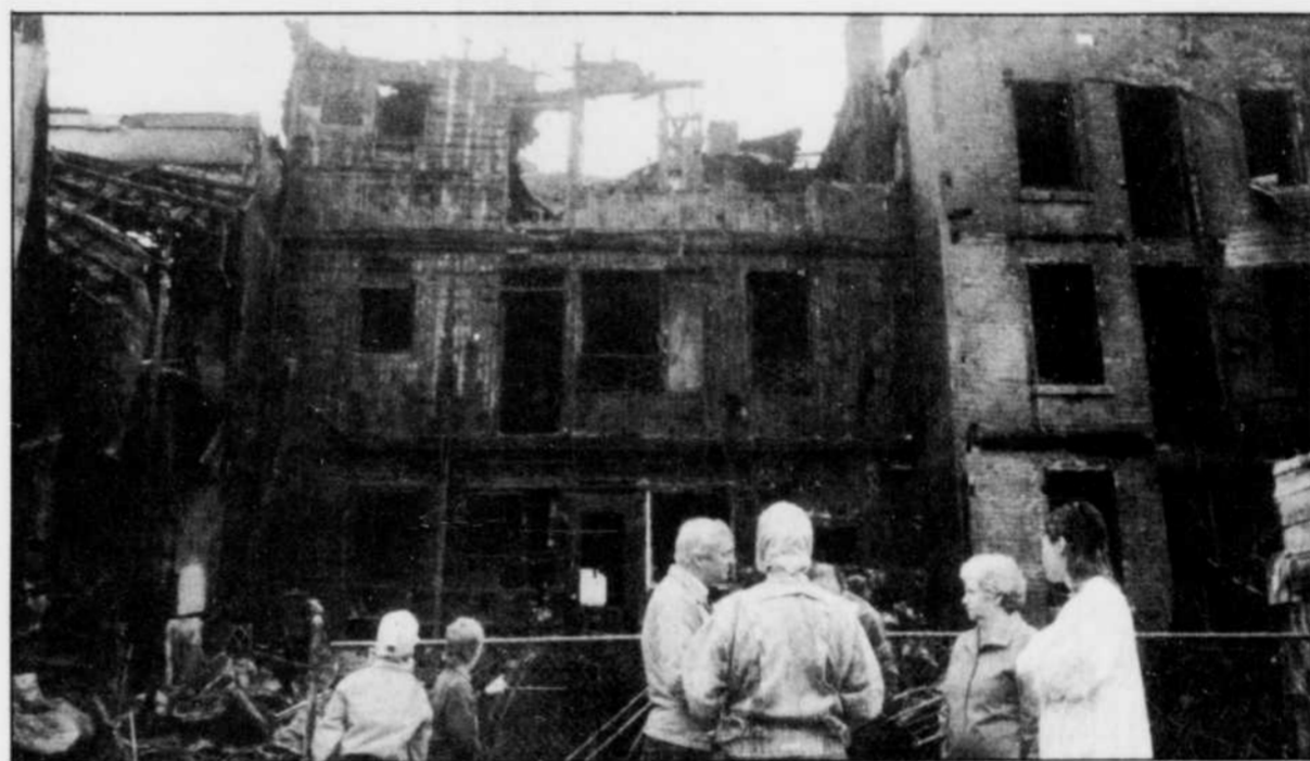
Devant des gens consternés et apeurés, un aperçu des dégâts aux trois édifices à logements.
