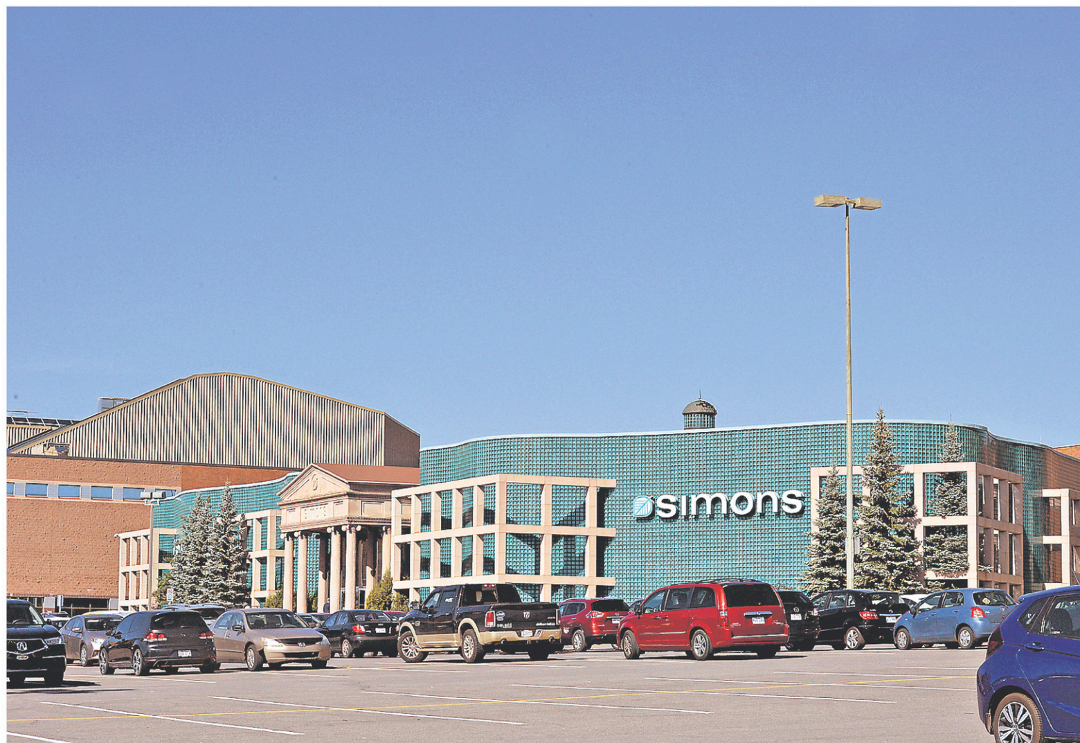
La construction d'un hôtel au-dessus de l'actuel local de Simons aux Galeries de la Capitale est envisagée par le Groupe Oxford, copropriétaire du centre commercial. — PHOTO LE SOLEIL, PATRICE LAROCHE
