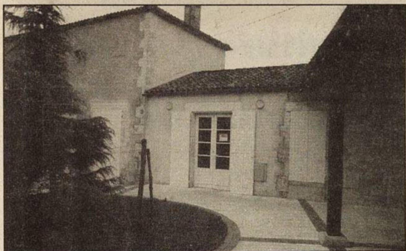
Bureau de la mairie: la salle du Conseil est dans la portion gauche de l'édifice et le bureau du maire du côté droit.
