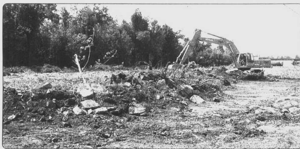
Des travaux de défrichage ont été amorcés sur le terrain situé au 1555, rue des Échevins dans le secteur Saint-Luc.
