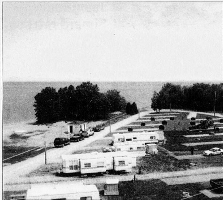
CAMPING ET AUBERGE - En plus d'ajouts d'emplacements de camping, Gerry Desmeules parle de la construction d'une auberge en bois rond de 48 chambres, un investissement de 3M$.
