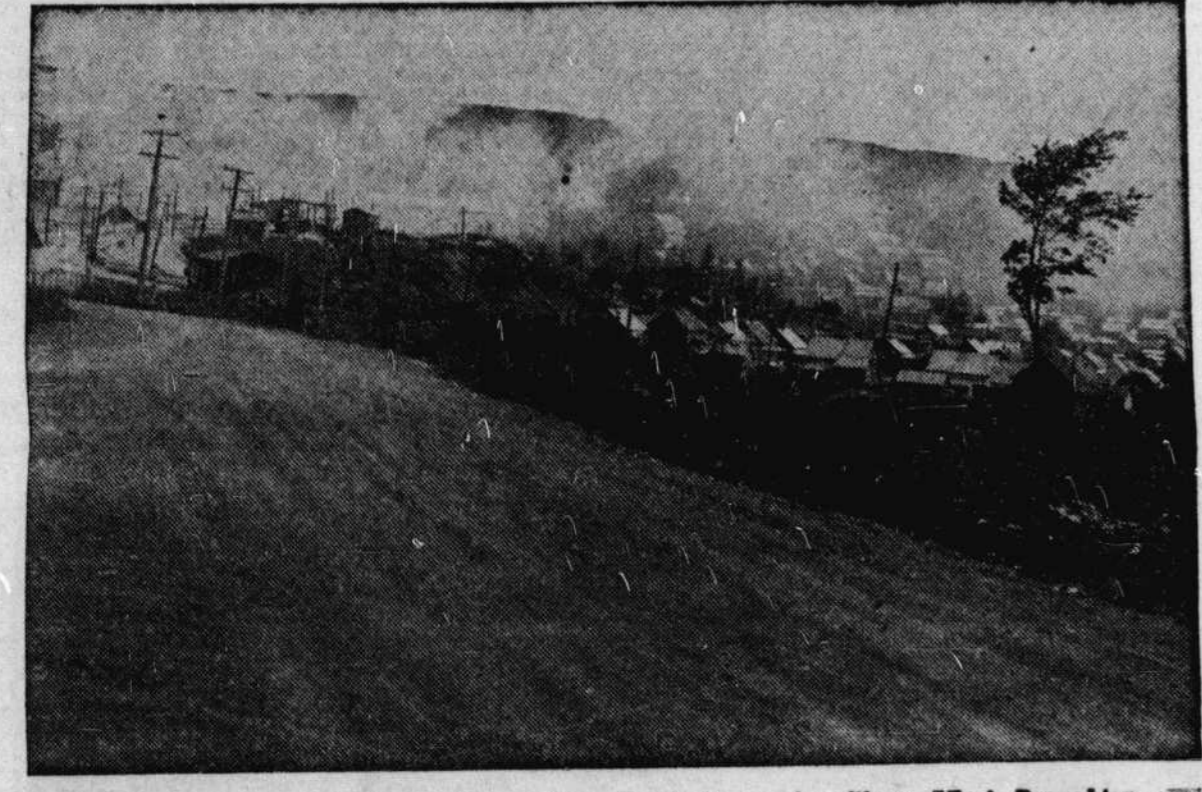
Le moulin vomit des tonnes de poussière d'amiante sur le village d'East Broughton.
