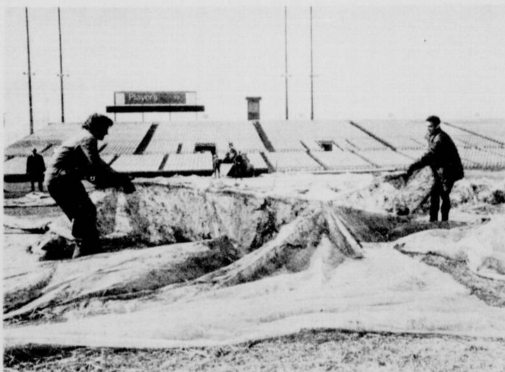
L'opération est réussie. Les ouvriers retirent l'immense couverture de plastique qui recouvrait le champ intérieur déjà protégé par de la paille. Le terrain est à peine humide.
