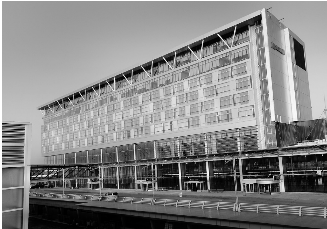
Le complexe hôtelier Marriott dévoilé hier à l'aéroport Trudeau comprend un hôtel de 229 chambres et de bureaux qui abriteront le siège social d'Aéroports de Montréal.
