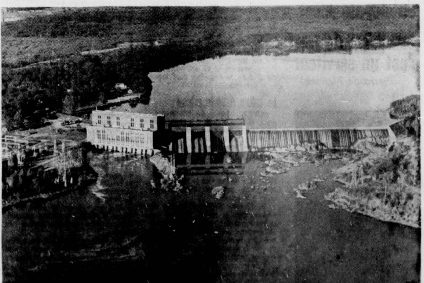
... même si la rivière St-François peut suffire à la tâche, l'usine de filtration reste la clé du système d'aqueduc.
