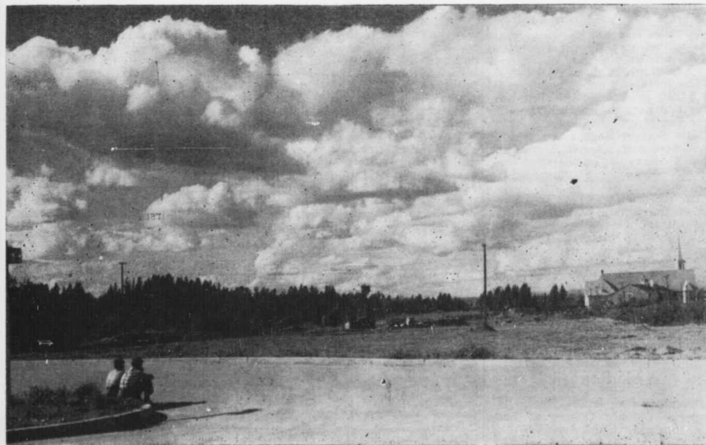
On a commencé des travaux de grande envergure dans le quartier Vaudreuil d'Arvida en vue de l'aménagement d'un magnifique parc de 48 acres. On distingue ici une puissante pionnière nivelant une partie de ce vaste terrain. Au premier plan, deux jeunes Arvidiens, Rosaire Rainville et Jean-Yves Levesque rêvent déjà des bons moments qu'ils passeront à cet endroit.
