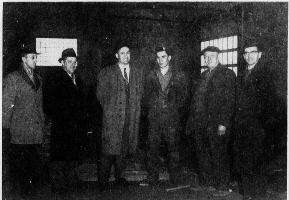
M. Thomas Bellemare directeur du Comité local d'emploi d'hiver a appuyé personnellement l'organisation en construisant son nouveau garage durant les mois d'hiver. Les travaux se poursuivent.
