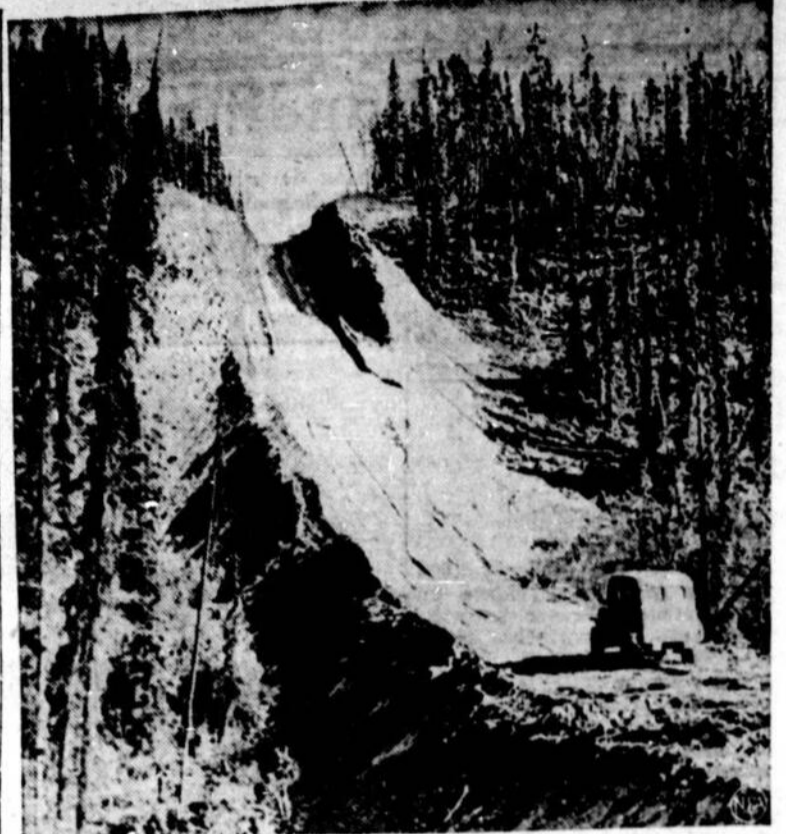
La construction de la route militaire à travers le Canada, reliant les Etats-Unis à l'Alaska, est un exploit du génie américain. Longue de 1,671 milles, elle a été terminée en 6 mois. Il a fallu traverser 200 cours d'eau, combler une infinité de ravins, etc. Cette photo montre un endroit typique de cette route, où il a fallu abaisser la crête d'une colline et combler la vallée.
