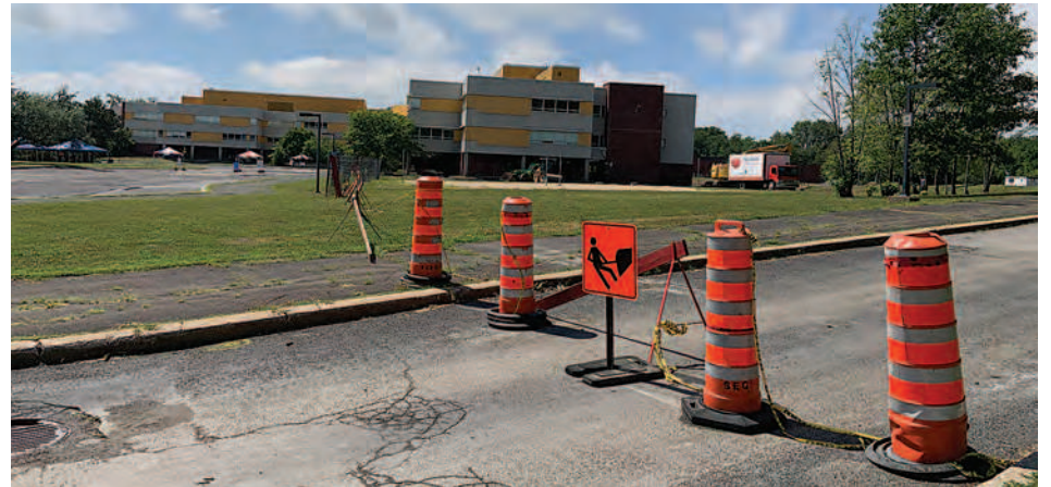
À l'École secondaire du Mont-Bruno, des travaux ont lieu dans le stationnement arrière. (Photo : Frank Jr Rodi)
