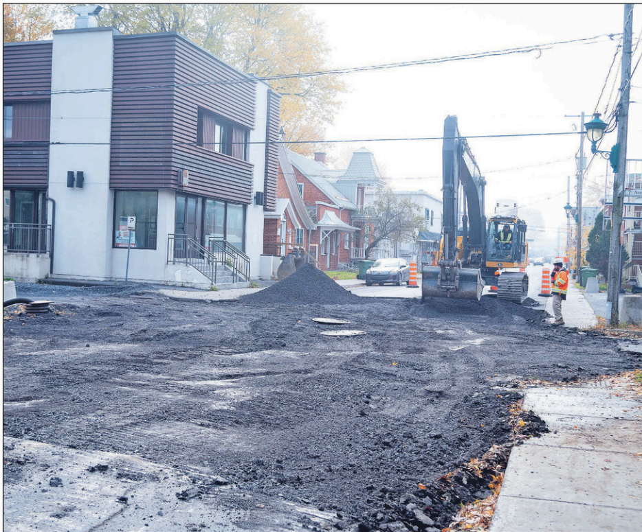
Cette phase du chantier doit permettre de brancher le collecteur sanitaire et d'amener le collecteur pluvial jusqu'à la rivière.
