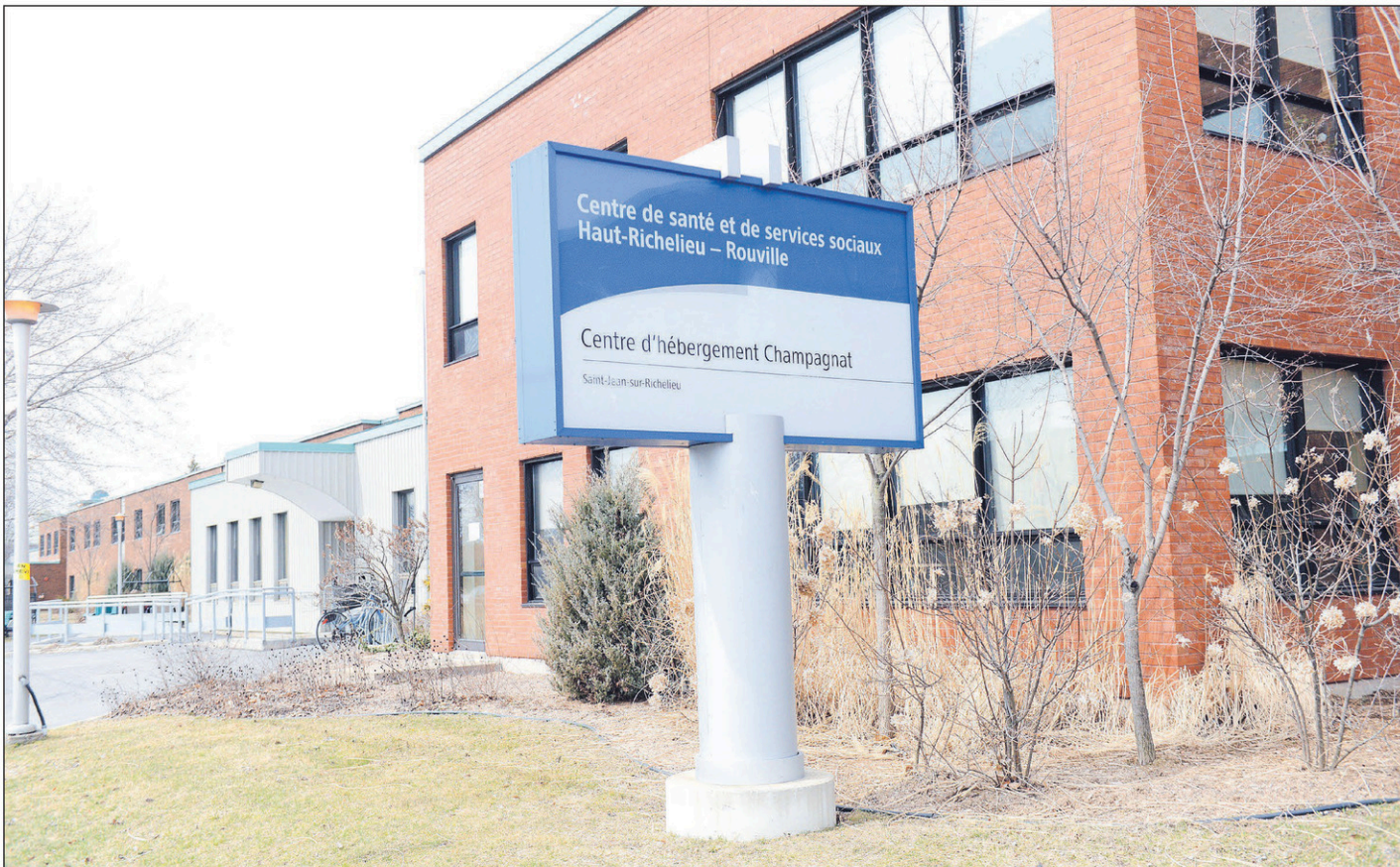
La direction du CHSLD croyait avoir le temps de réaliser les travaux d'entretien de son système de plomberie avant de commencer à chauffer l'édifice.
