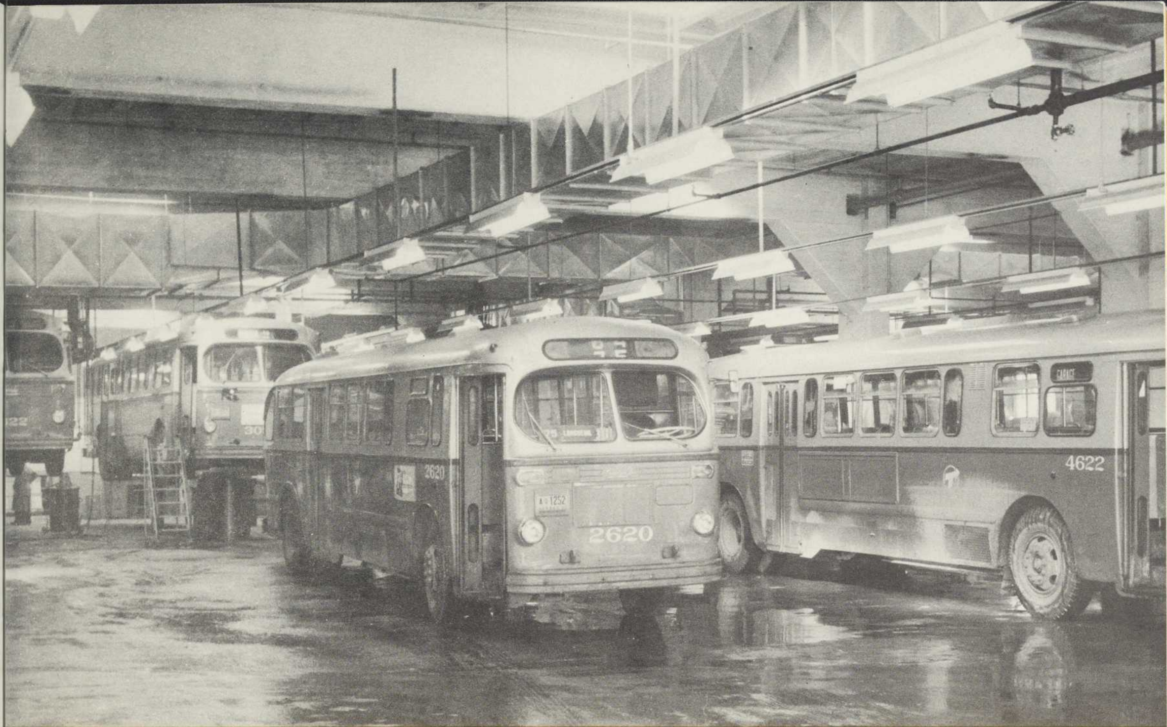
Vue de l'intérieur du garage St-Michel
