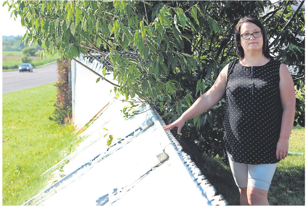
Josée Ranger devant sa clôture endommagée — PHOTO CHRISTOPHE BOISSEAU-DION
