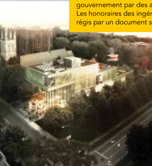
Agrandissement du Musée national des beaux-arts du Québec, Office for Metropolitan Architecture, Provencher Roy associés
