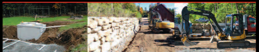
INSTALLATION DE FOSSE SEPTIQUE
