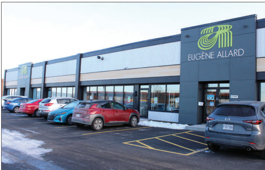
Signature AP et le projet d'entrepôt d'Eugène Allard sur la rue Watt.
