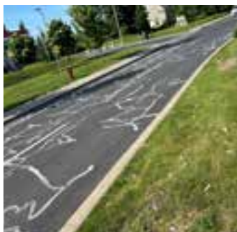
Scellement de fissures sur le boulevard Clairevue Ouest
