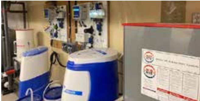
Piscine Roberval | Travaux d'automatisation des produits chimiques : remplacement du chlorinateur et contrôleur de pH
