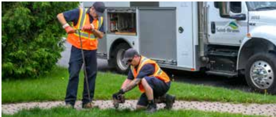
Installation des compteurs d'eau résidentiels : vérification des boîtes de service des citoyens volontaires dans le cadre de la campagne « Je m'engage pour l'eau »
