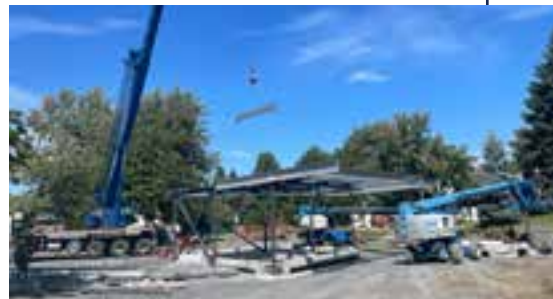
Réaménagement complet du parc Jolliet (5,5 M $)
