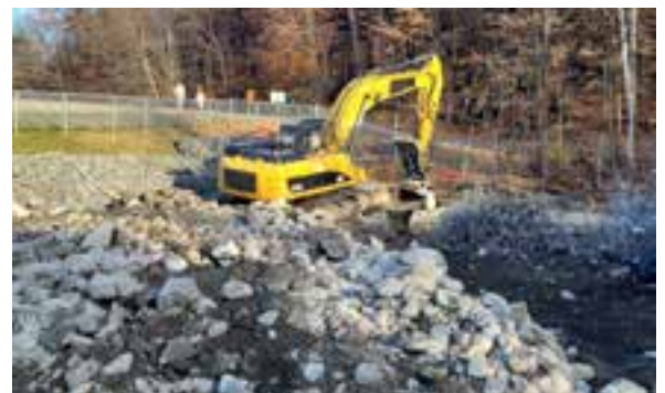
Démolition de la station de pompage PS7
