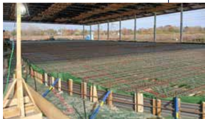
Construction du nouveau polydôme (15 M $)
