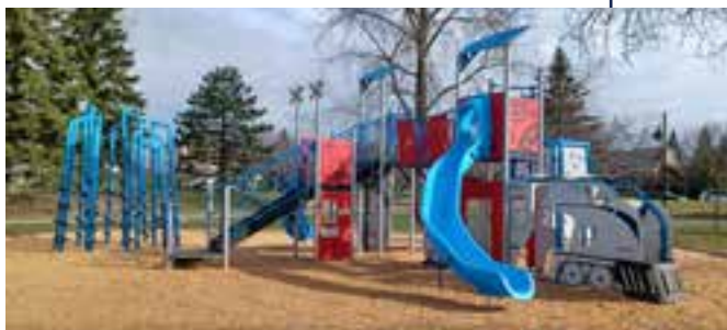
Remplacement des modules de jeux au parc Quincy-sous-Sénart
