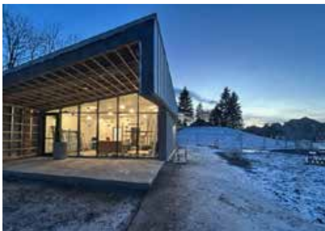
Construction d'un chalet au parc Jacques-Rousseau (1 M $)
