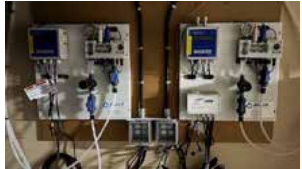
Piscine Roberval | Travaux d'automatisation des produits chimiques : remplacement du chlorinateur et contrôleur de pH
