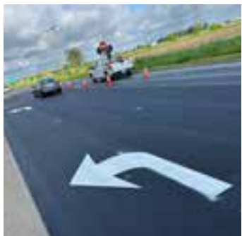
Resurfacement de la montée Montarville
