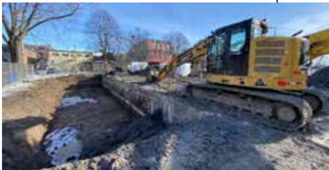
Démolition du pavillon technique
