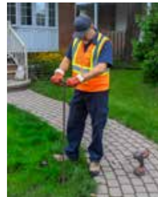
Installation des compteurs d'eau résidentiels : vérification des boîtes de service des citoyens volontaires dans le cadre de la campagne « Je m'engage pour l'eau »
