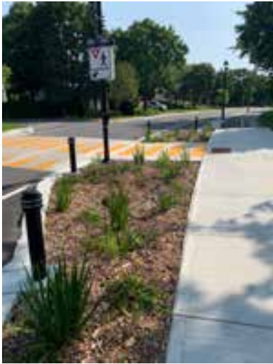
Plantation de nouvelles noues et de saillies sur les rues Joliet et Marquette
