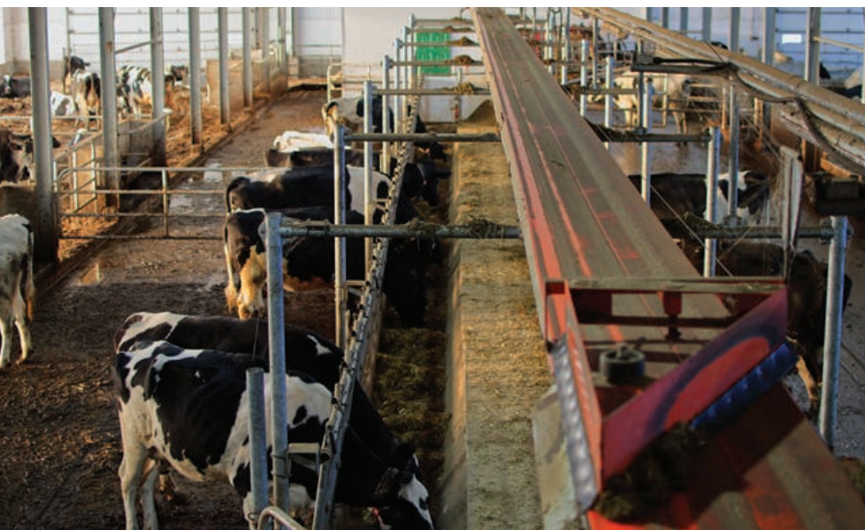
Une des caméras de la Ferme J.R. Beaudoin et Fils est braquée sur le convoyeur d'alimentation. Elle permet de s'assurer de son bon fonctionnement et de vérifier en même temps l'état des mangeoires.
