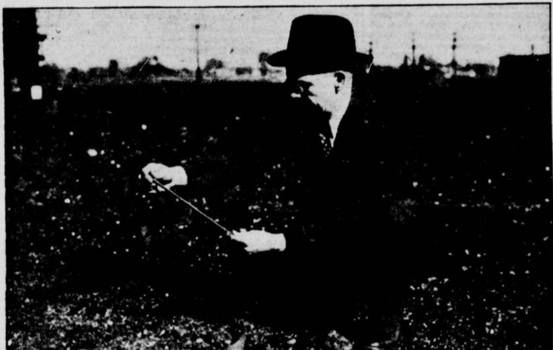
Il importe de surveiller le degré de température du charbon. Le thermomètre que tient en main M. G.-W. Boggis, surintendant du service des combustibles au Canadien National, marque 125 degrés, alors que 140 degrés constituent le point de combustion. On évite le danger de l'inflammation en pratiquant des prises d'air dans les accumulations de charbon. Le Canadien National s'est pourvu de 1,870,000 tonnes de charbon à locomotive en prévision d'une circulation très intense au cours de l'hiver. (Photo Canadien National)
