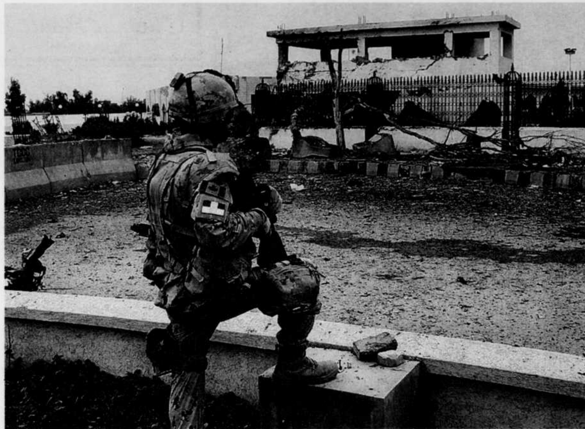
Un soldat canadien contemple le bâtiment de l'assemblée provinciale détruite mercredi à Kandahar. Le Canada aidera à sa reconstruction.
