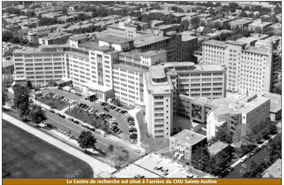
Le Centre de recherche est situé à l'arrière du CHU Sainte-Justine
