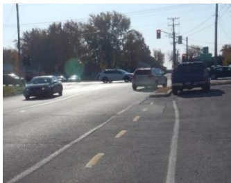
Fin de voie cyclable Source : DSPu Montérégie
