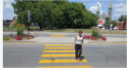
Exemple d'îlot refuge (DSPu Montérégie)
