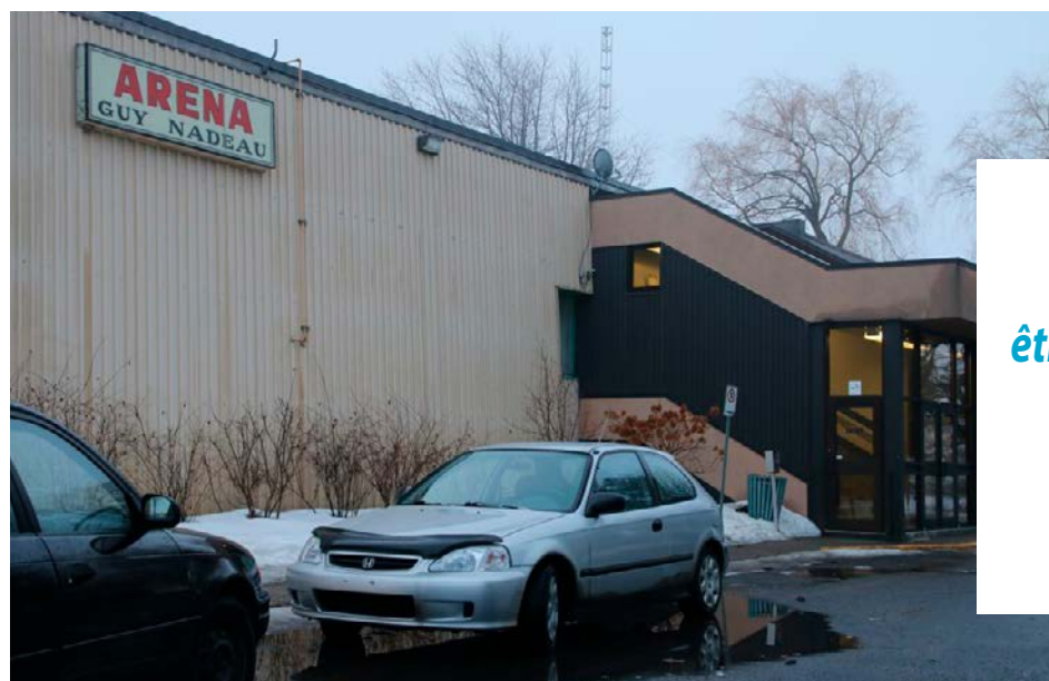
Depuis 2017, l'aréna Guy-Nadeau est fermé en raison de sa décrépidité.
