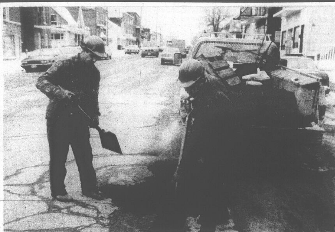
Les employés du Service des travaux publics de Lac-Mégantic ont effectué beaucoup de rapiéçage au cours des derniers jours dans les rues de la Ville. L'asphalte froid a été utilisé pour colmater les trous.
