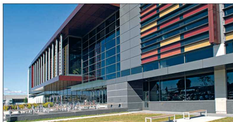
Le pavillon Ferdinand-Vandry de l'Université Laval a reçu le Mérite, catégorie Édifices publics et institutionnels, rénovation. — PHOTO FOURNIE PAR LE MÉRITE D'ARCHITECTURE 2009
