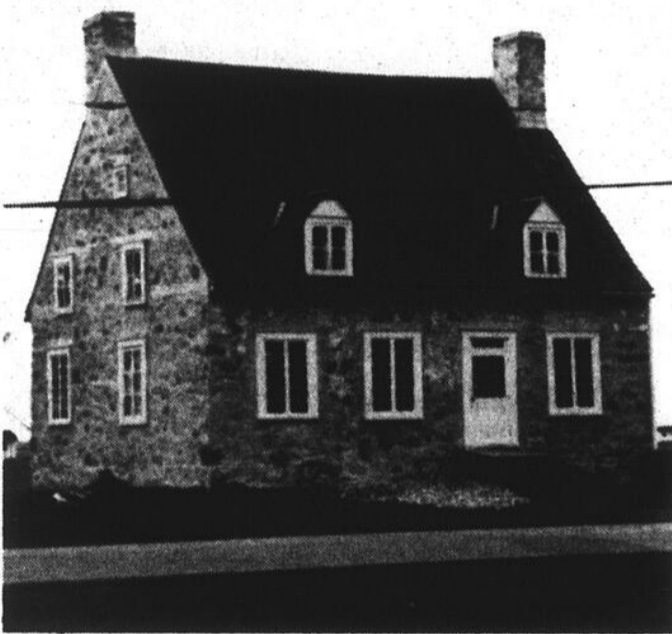
La maison Camiré (Saint-Luc) est sans doute la plus vieille du Haut-Richelieu; sa construction remonte à la fin du 18 ème siècle. Les ouvertures sont grandes et nombreuses: cela suppose une influence étrangère. Par contre, leur asymétrie démontre qu'elles ont été pratiquées en fonction de la division intérieure.
