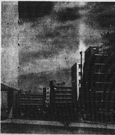
Una veduta di nuovi isolati in Calgary, Alberta.
