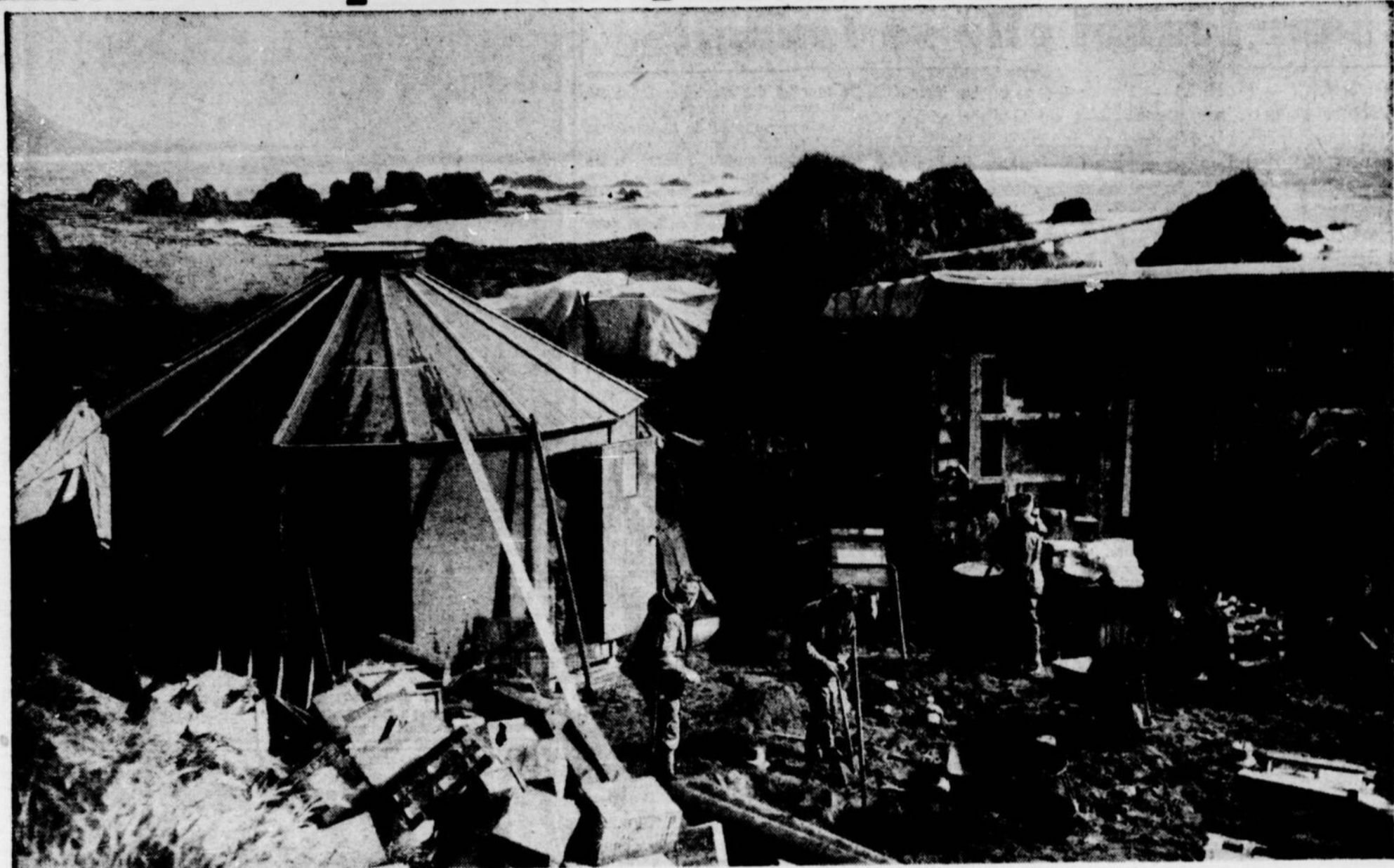
Cette magnifique photo a été prise au pôle sud, au siège de l'expédition australienne dans l'île Macquarie. On voit, à droite, la baraque construite, en 1912, par sir Douglas Mawson, célèbre explorateur australien, et, à gauche, la hutte du type "Signal Corps", qui a été élevée par les hommes du capitaine Campbell, chef de la présente expédition.
