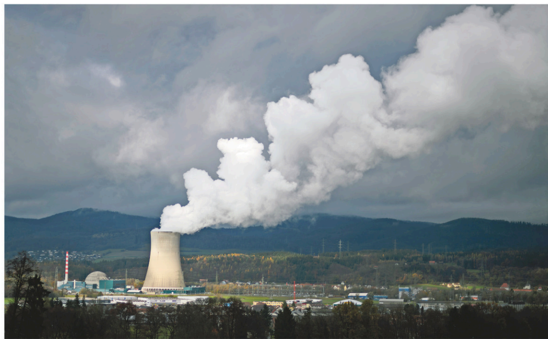
La centrale nucléaire Gösgen, près de Däniken dans le nord de la Suisse
