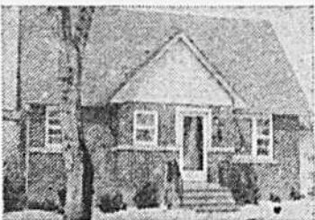
29-CARTIERVILLE: luxueux cottage chauffé à l'électricité, patio, salle de lavage, propriété impeccable. Michelle Nagy, 334-5330.
