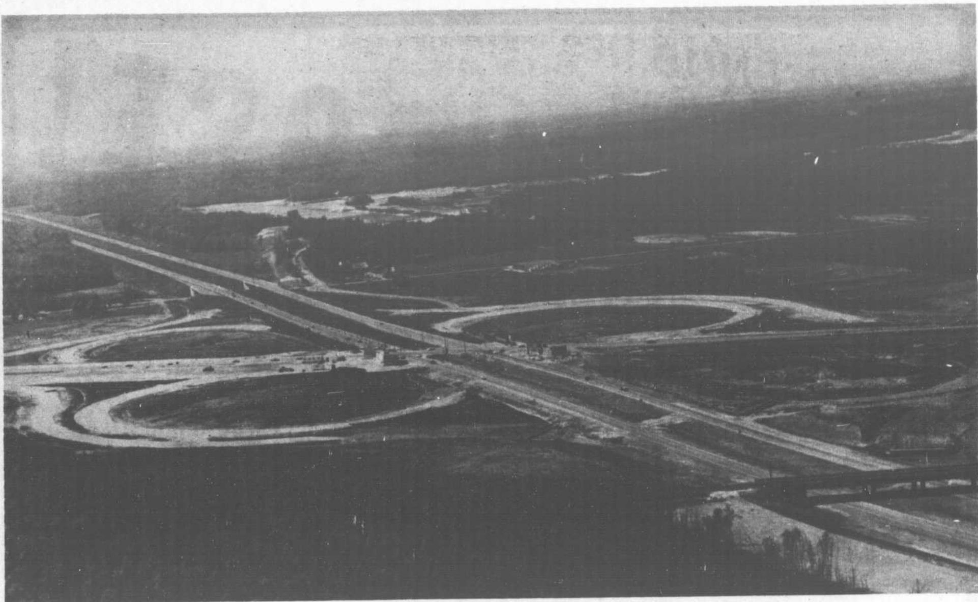
LA VUE D'ENSEMBLE DES GRANDS TRAVAUX actuellement en cours au carrefour des autoroutes 640 et 25, l'immense trèfle des voies d'accès et de sortie. A droite, au premier plan, le viaduc du chemin de fer Pacifique Canadien au-dessus de la 640.
