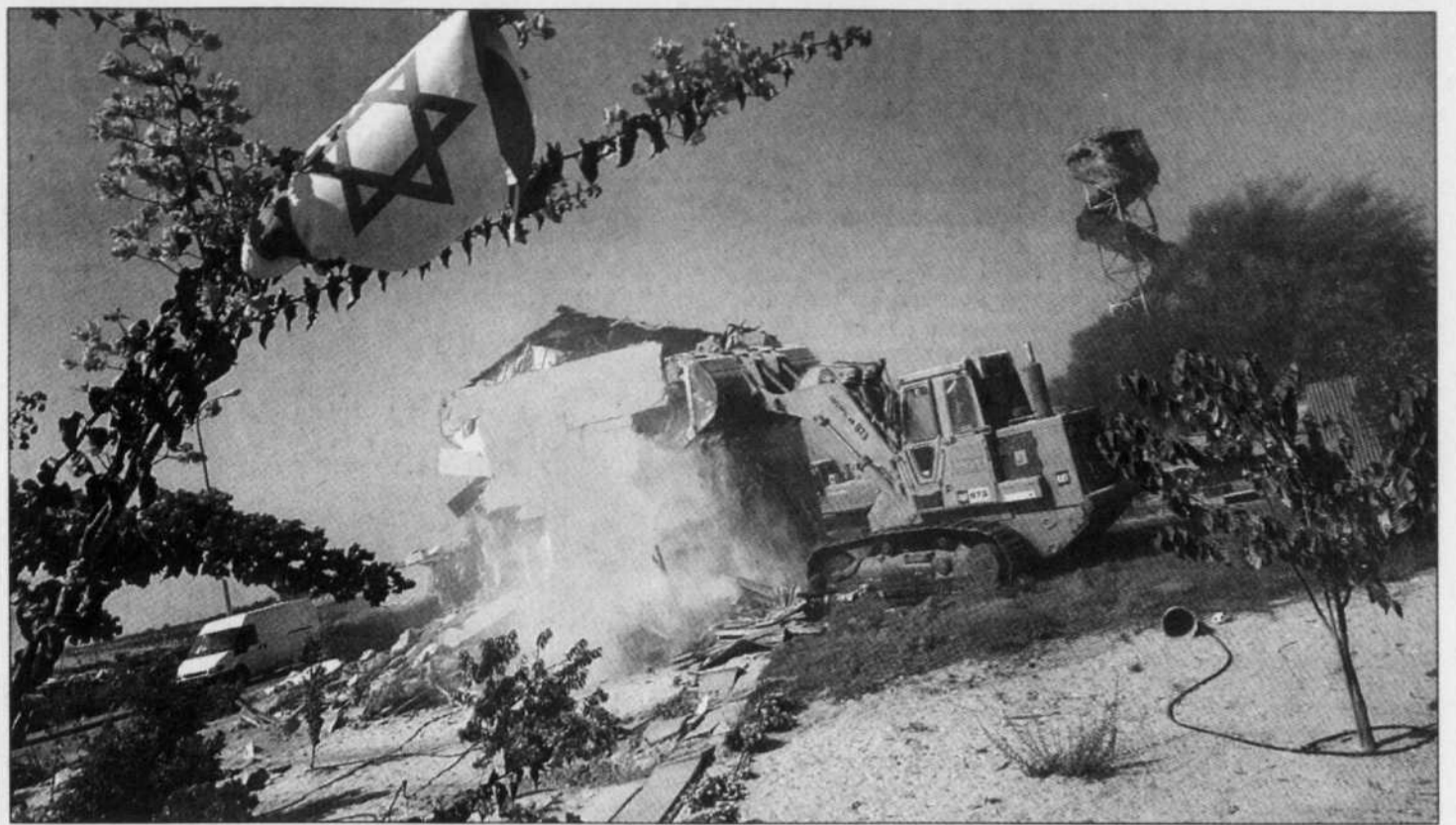
Israël a commencé la démolition des maisons des colons de Morag.
