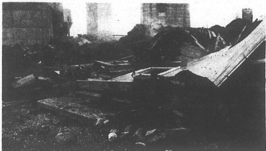
Malgré l'ampleur du sinistre, cours de l'opération (Photos François Ménillo).
