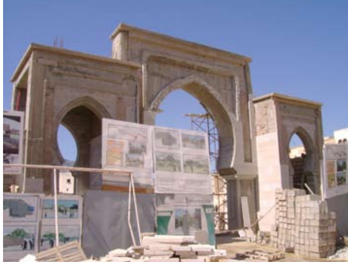
Les travaux vont bon train sur le site du chantier lauréat du Global Holcim Awards Gold 2009 situé à Fez, au Maroc, ville qui fait partie du patrimoine mondial de l'UNESCO.
