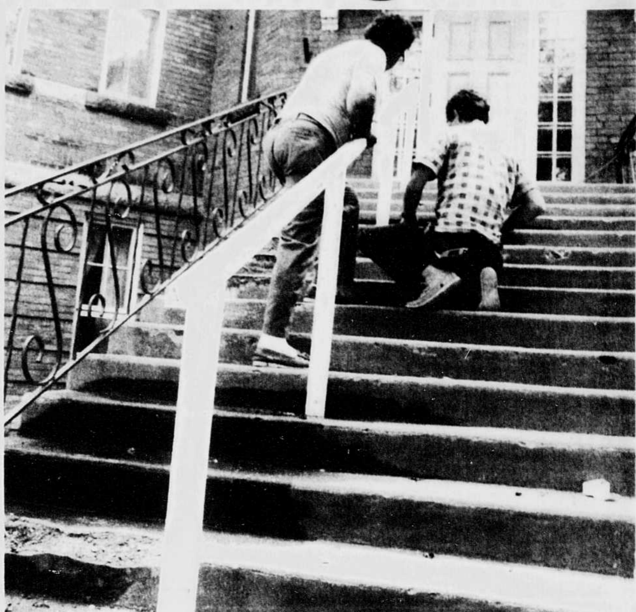
Dès hier après-midi, les employés du service d'entretien de l'OMHS s'attairaient à effectuer des réparations temporaires d'urgence aux escaliers en désintégration des Habitations Ste-Marie.
