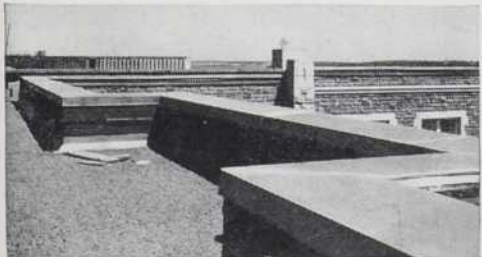
Reverseaux en Monel sur la toiture de l'université St. Mary's, à Halifax, N.-E. Entrepreneurs: James Donahue Limited, Halifax, N.-E.
