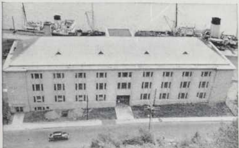
Toit en Monel sur l'immeuble de la Marine, à Québec, P.Q. Entrepreneurs pour la toiture: Adelaar Laberge Liée, Québec, P.Q.
