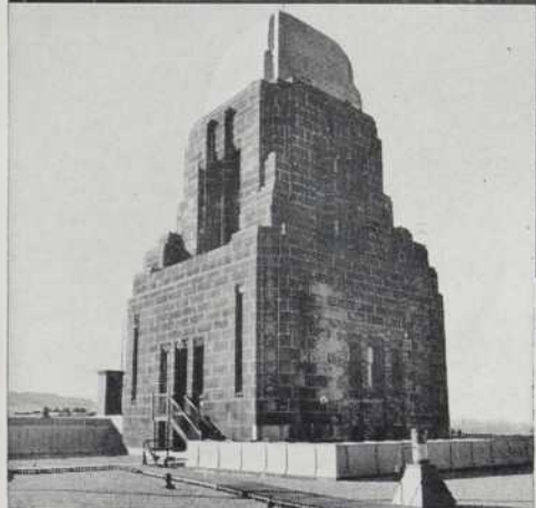
L'édifice du gouvernement fédéral, à Halifax, N.-E., dont la toiture est en Monel. Entrepreneurs: Northern Roofing and Metal Workers Ltd., St-Jean, N.-B.
