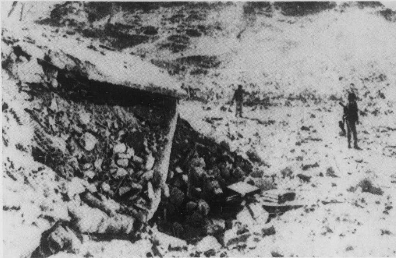
Un Palestinien armé contemple les débris d'une maison de Azzieh, village du Sud-Liban qui a été complètement rasé par les bombes de l'aviation israélienne mercredi. (Téléphoto AP)
