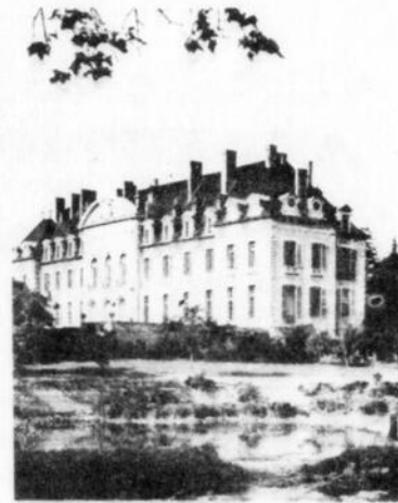
Château de La Ferté à Saint-Ambreuil
