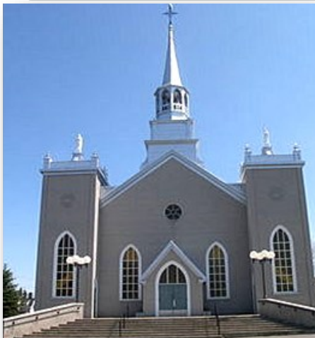
Église de Sainte-Hélène construite par François Soucy de 1847 à 1849
