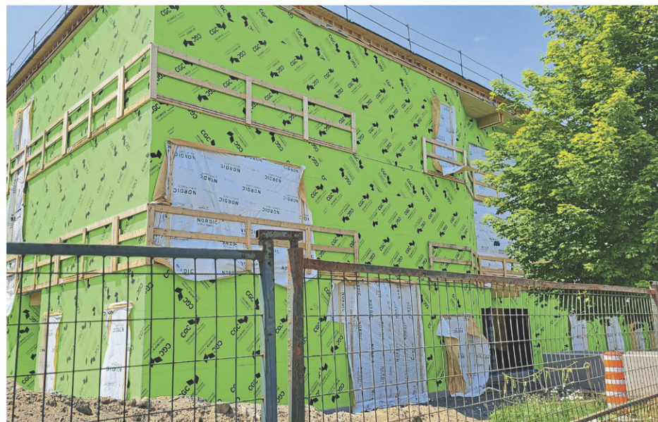
Les travaux de construction du nouveau centre administratif de la MRC de L'Érable, sur l'avenue Saint-Édouard à Plessisville, respectent l'échéancier prévu. Le chantier se terminera au printemps 2024. (Photo www.lanouvelle.net)
