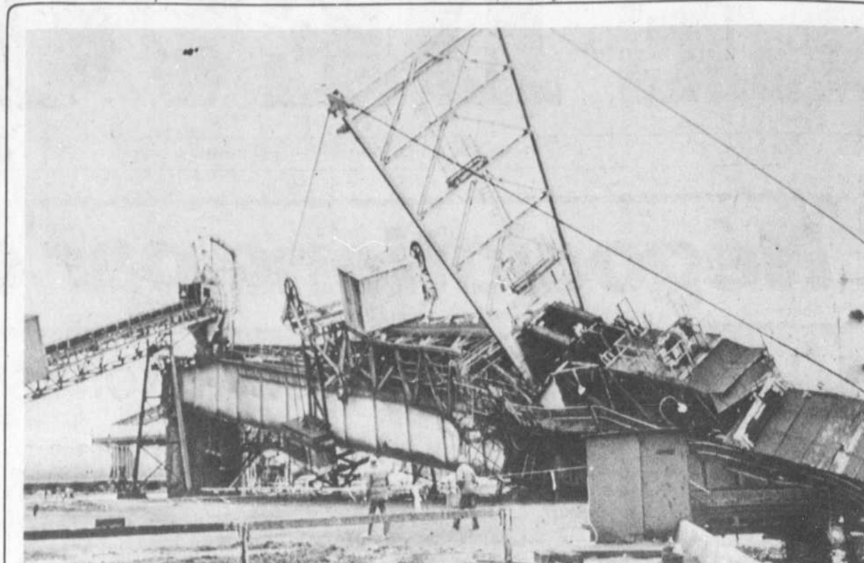
Ce convoyeur de charbon du port de Vancouver s'est écroulé sous les vents violents qui ont balayé la côte ouest au cours de la fin de semaine. (Photolaser CP)
