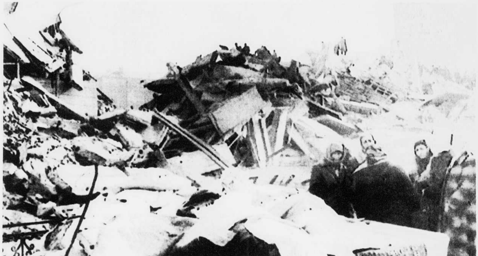
Le temps s'est également arrêté ce 7 décembre pour des centaines de milliers d'Arméniens touchés par un séisme mesuré 7.2 sur l'échelle de Richter. Ecoles, usines, immeubles détruits en une poignée de secondes, comme ici à Leninakan.
