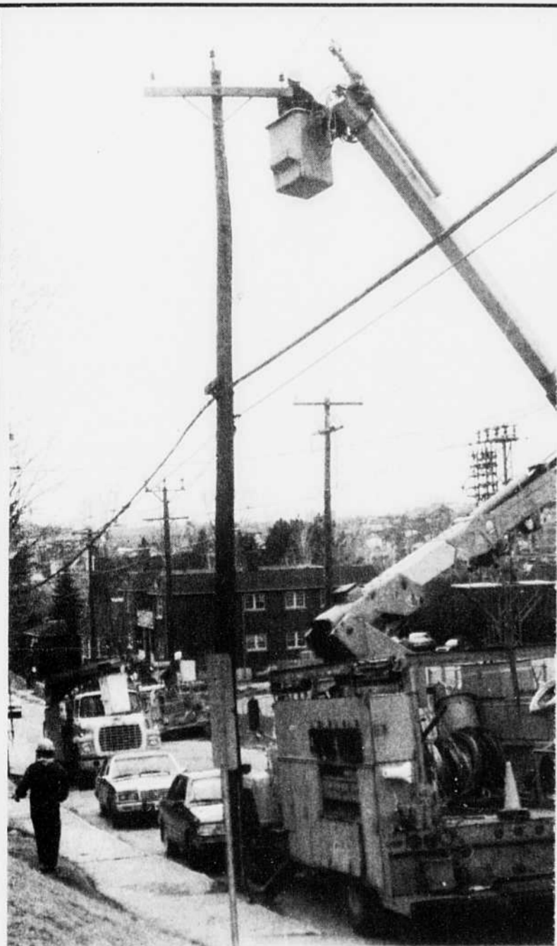
La fiabilité du réseau d'Hydro-Québec en a pris pour son rhume en 1988: les pannes de courant sont en hausse de 30 pour cent par rapport à l'an dernier.
