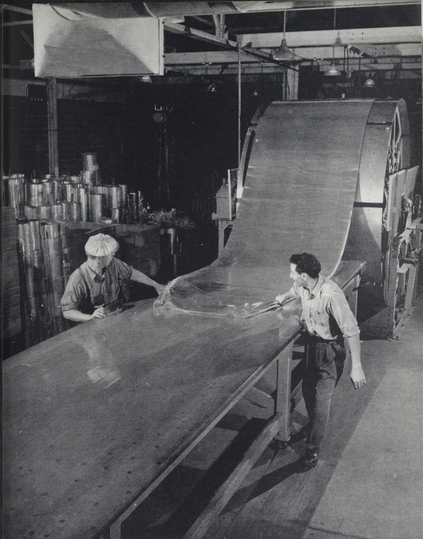
On s'apprête à couper des feuilles de cellophane à la grandeur désirée dans une manufacture de Shawinigan Falls.
