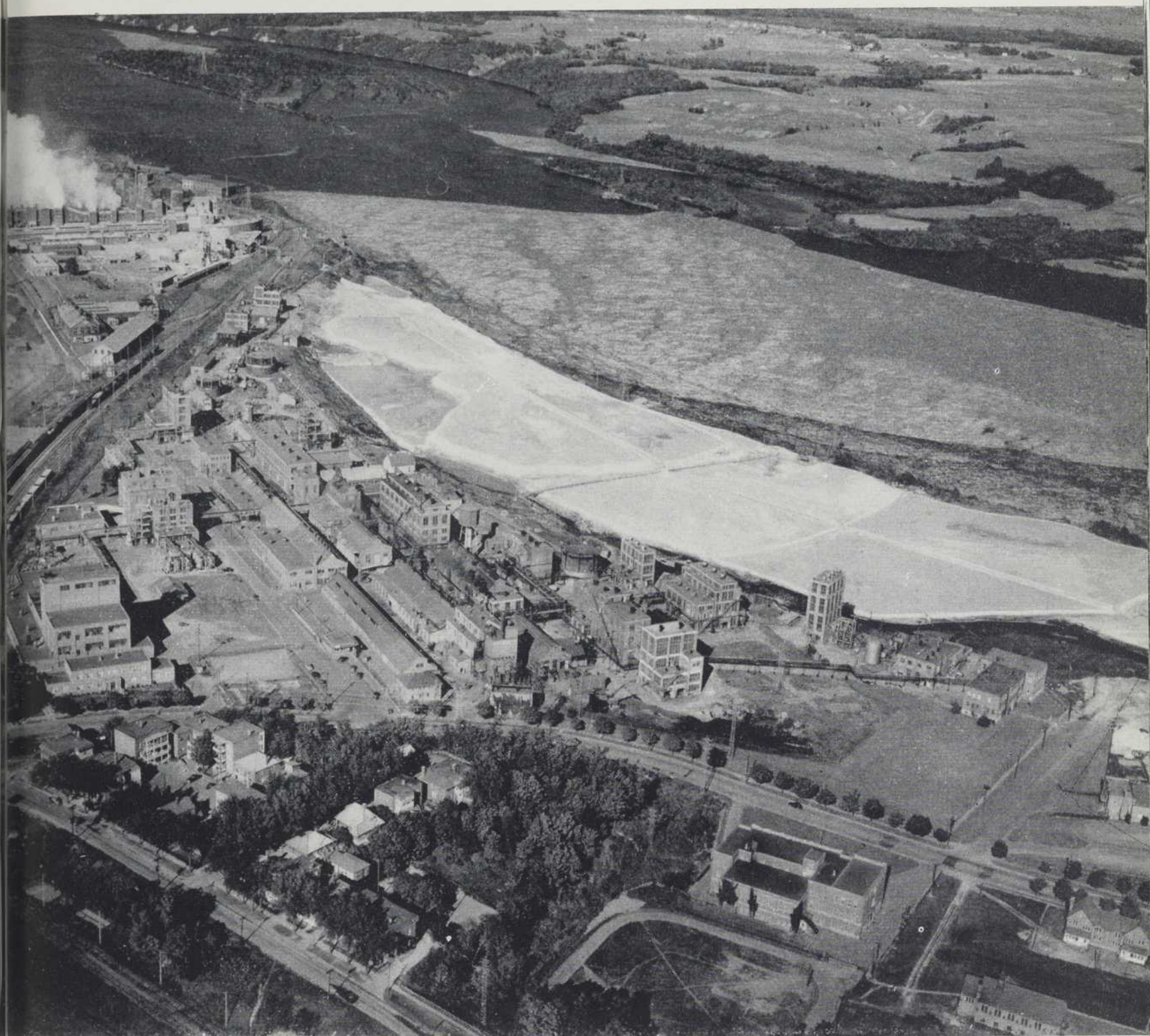
La petite fabrique de carbure de calcium établie près des chutes Shawinigan, il y a 50 ans, s'est transformée en une puissante industrie de produits chimiques. Cette photographie aérienne donne une idée de la superficie du terrain occupée aujourd'hui par ses établissements.
