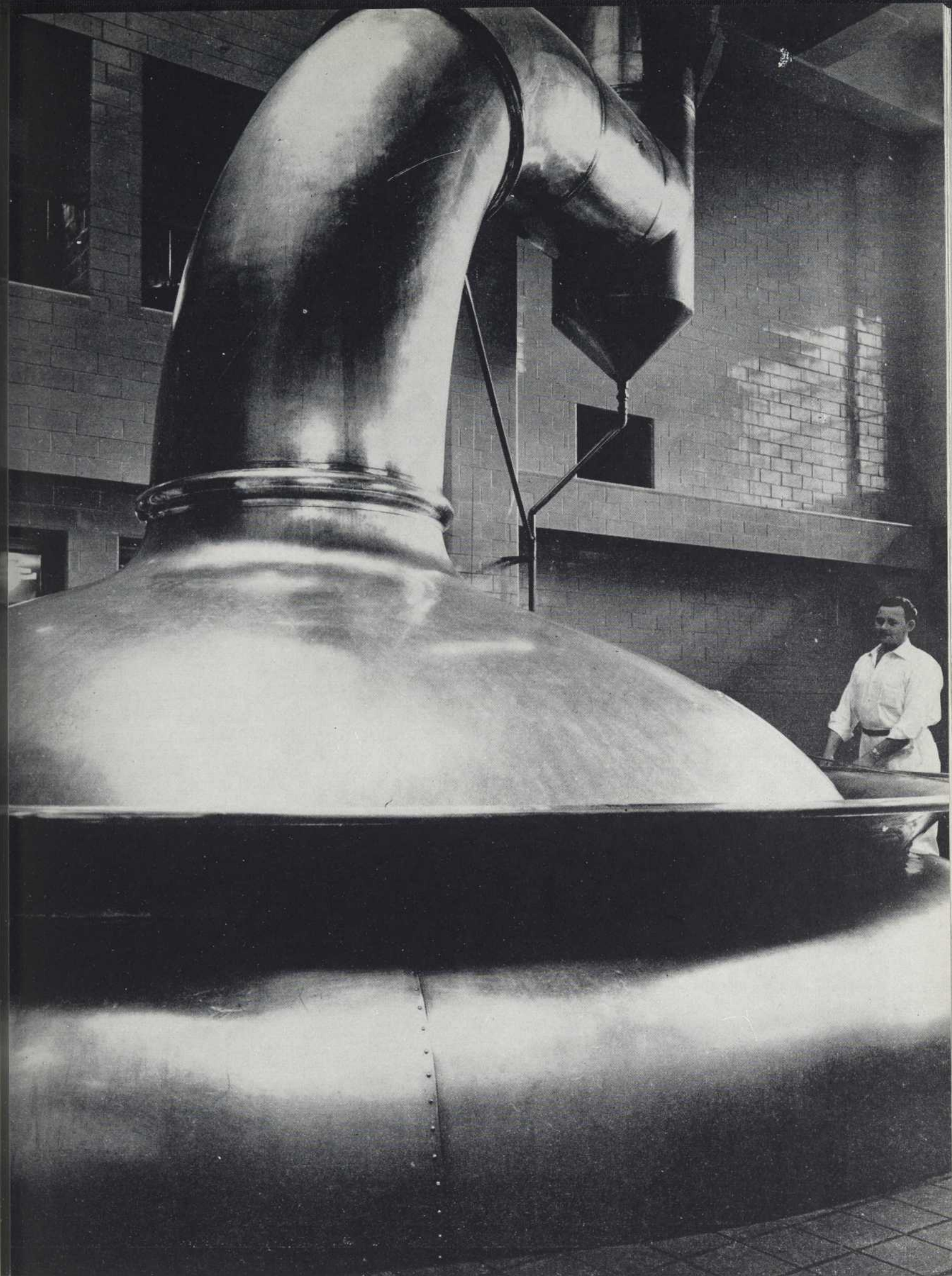
L'industrie de la bière est l'une des plus anciennes institutions manufacturières de la province de Québec. — Dans ce gigantesque bouilleur de 20,000 gallons, le brassin est gardé en ébullition pour extraire tout le bouquet et la saveur du malt et du houblon.
